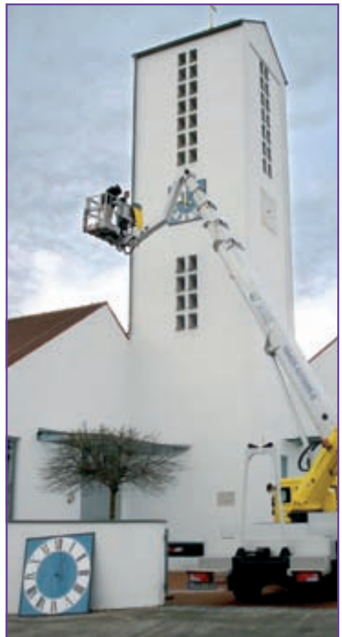
RÜCKBLICK: Demontage der Kirchturmzifferblätter Ende Januar Foto: privat
